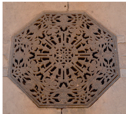
Grille de fonte disposée au sol pour le chauffage.
